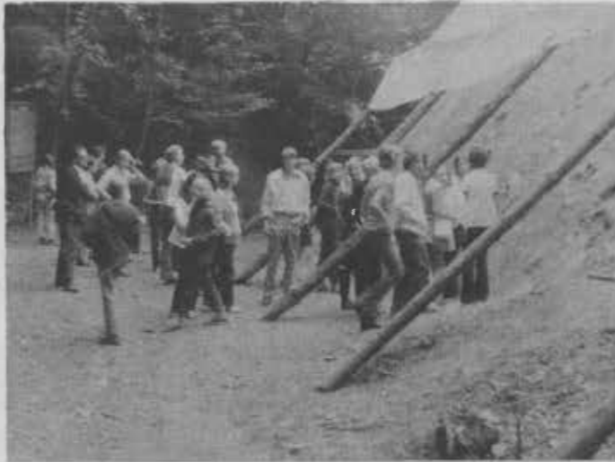
Unser Foto zeigt die Teilnehmer des Jugendlagers 1971 an dieser Stelle, als gerade wieder Instandsetzungsarbeiten im Gange waren.
