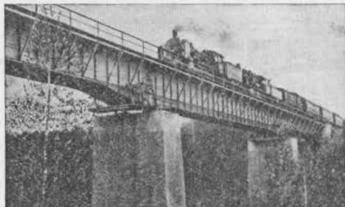
Viadukt der Bahnstrecke Tütz—Kallies
