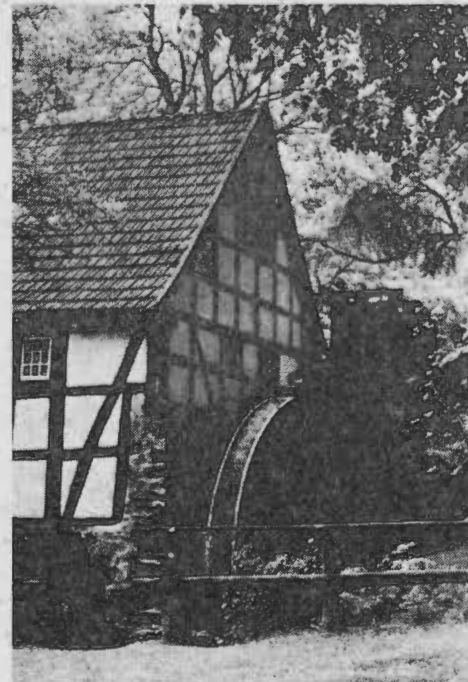
Die Alte Mühle in Bad Essen
