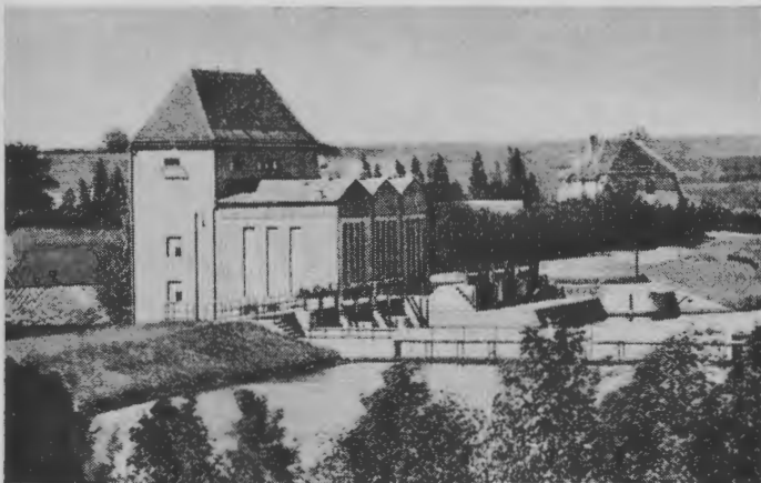
Das Küddow-Kraftwerk Borkendorf
