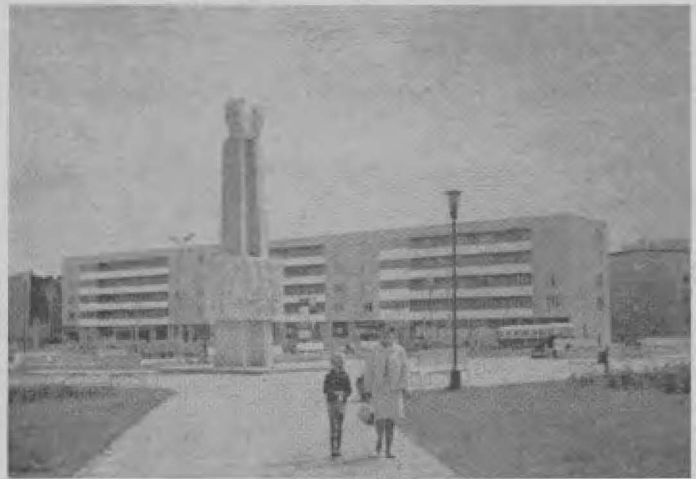
Blick von der Mühlenstraße auf Kl. Kirchenstraße (rechts nach der Posener- und links Gr. Kirchenstraße)
