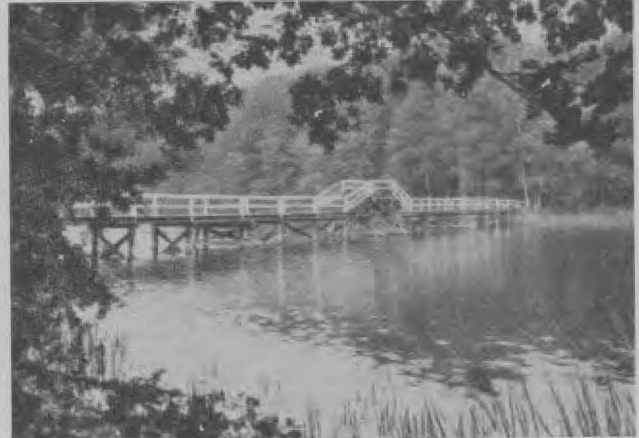
Die Klotzow-Brücke, die es damals noch nicht gab
