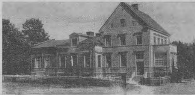
Das Gutshaus des rund 1000 Morgen großen Gutes ehem. Richard Senftleben in Arnshof.
