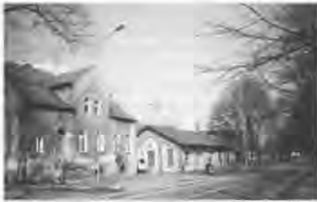
Ein Teil der Bergstraße mit Licht-, Kraft- und Wasserwerken.
