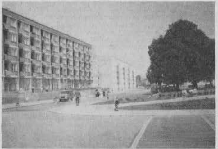
Die Rathausseite des Marktplatzes mit Blick in die Hasselstraße und dem Feuerwehrdepot im Hasselort.
