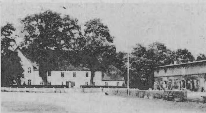
Der Gutshof vor dem Abbruch
