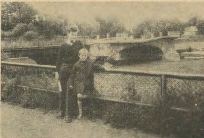
Schneidemühl: Die Karl-Krause-Brücke ist noch immer nicht wiederhergestellt.
