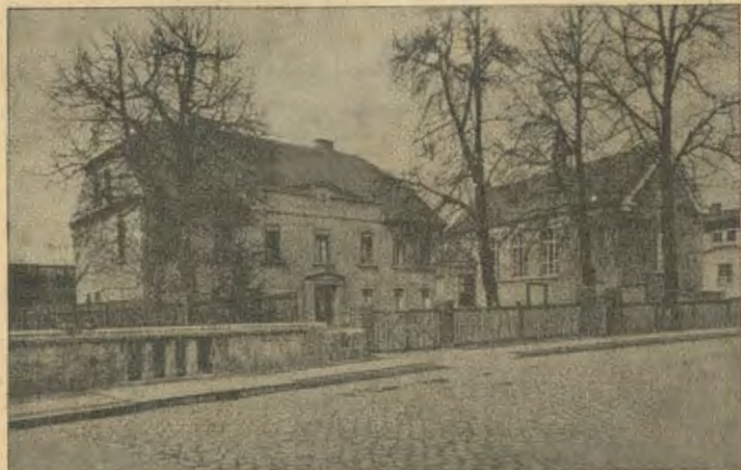
Das ev. Gemeindehaus Ecke Gamp- und Ritterstraße
