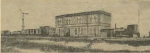
Bahnstation Deutsch Krone-West
