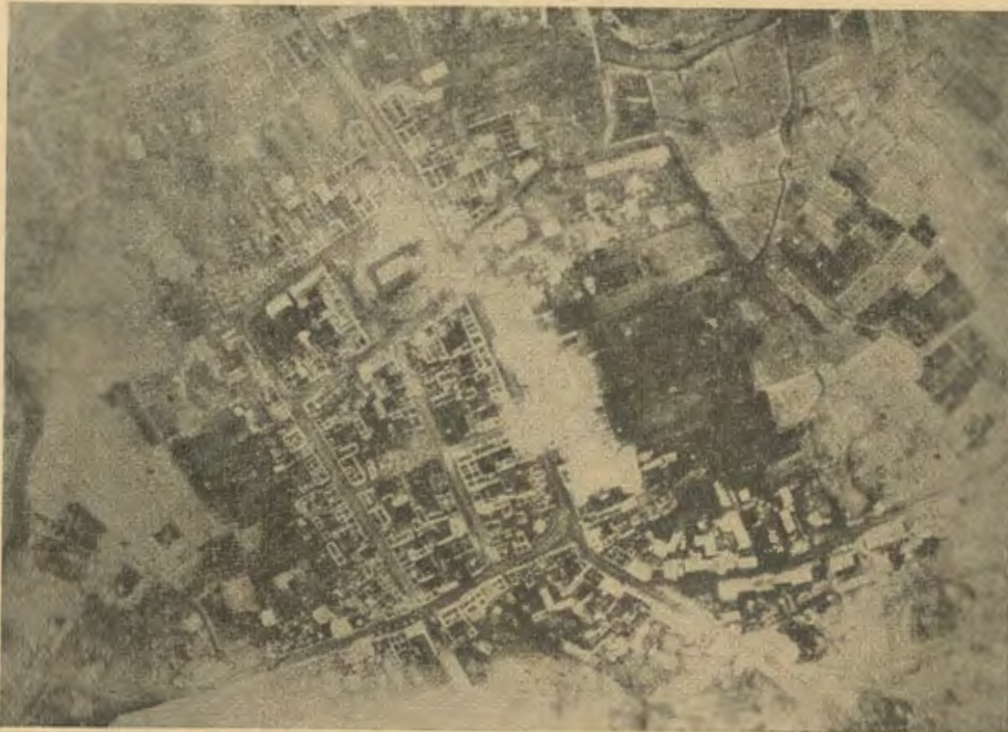
Luftaufnahme vom brennenden Schloppe
