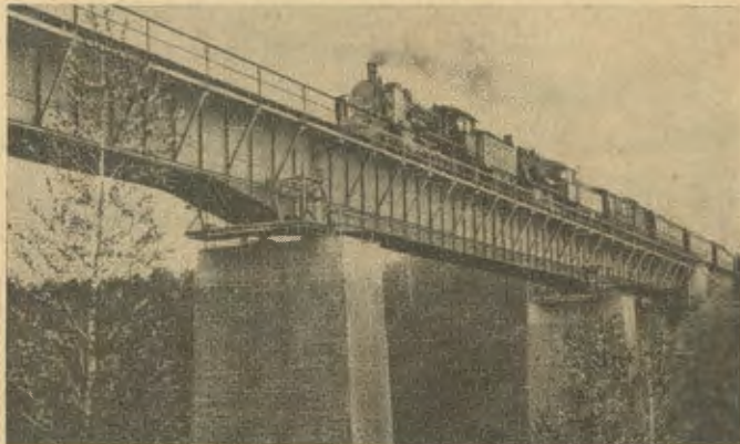
Bahn-Viadukt der Strecke Tütz — Kallies
