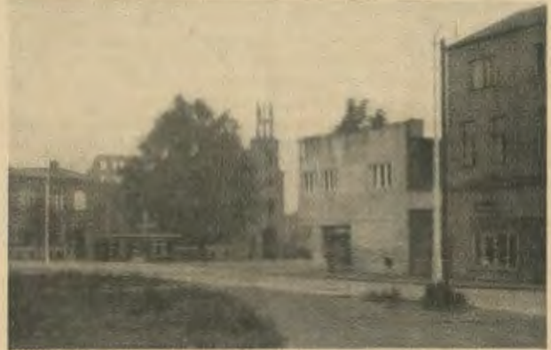
Blick auf die ausgebrannte Postruine (Altbau) aus der Wilhelmstraße. Heute stehen auf dem Trampelpfad bereits polnische Neubauten von der Posener Str. bis zum Wilhelmsplatz
