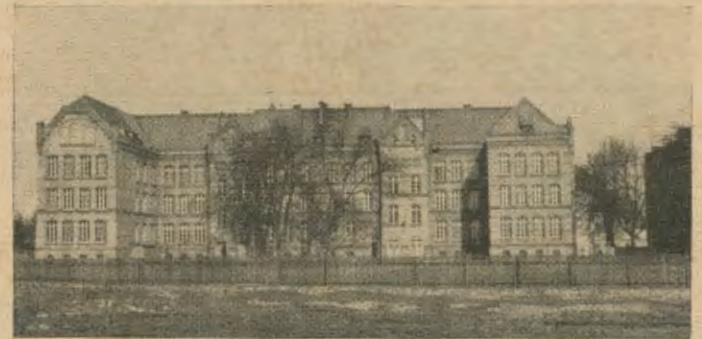
Die Rückseite der Bismarckschule, vom Baggengelände aus gesehen
