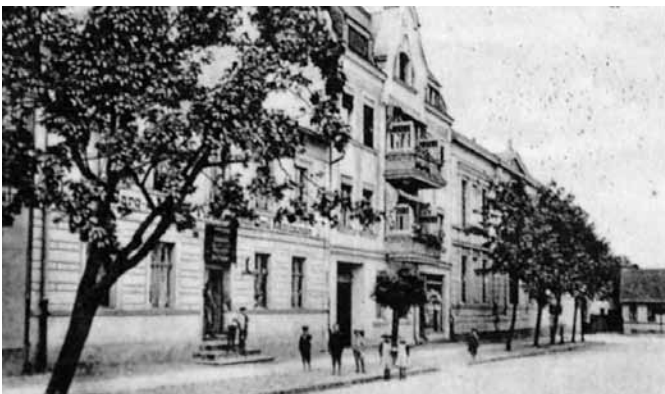
Die repräsentative „Logenseite“ des Hindenburg Platzes im Sommer 1938
