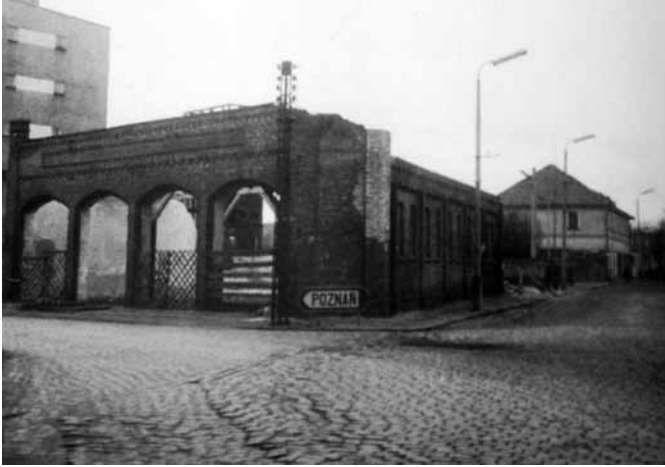
Das durch Kampfeinwirkungen beschädigte und danach durch die Russen durch Brand bis aufs Erdgeschoss zerstörte Feuerwehrdepot Ecke Eichblatt-Bäcker Straße i. Schneidemühl 1946.
