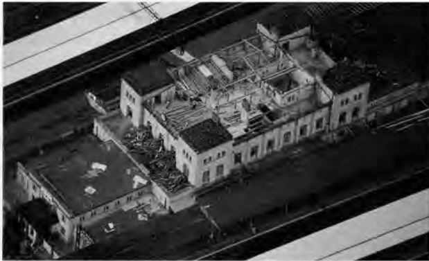
Umbauarbeiten aus der Vogelperspektive (wahrscheinlich im Sommer gemacht)
