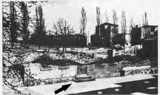
Von den großen Vergnügungsstätten „Reichsadler“ stehen nur noch ca. 1m hohe Reste der Grundmauern zur Bahnhofsstraße hin. Der nun freie Blick zum Danziger Platz zeigt das Landestheater und Landesmuseum 1948
