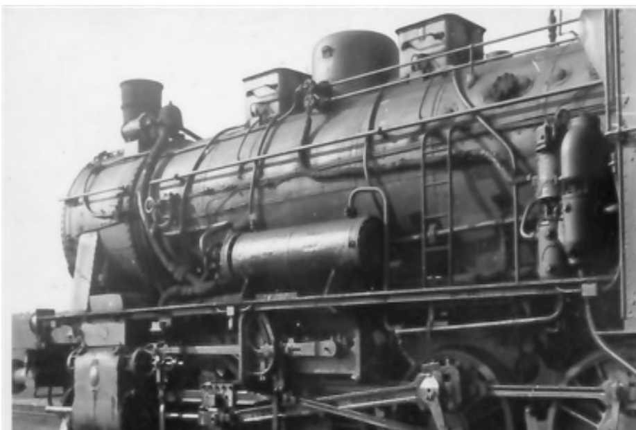
Reichsbahnausbesserungswerk Schneidemühl. Umgebaute G8 Lok nun mit Lauftrad, heißt jetzt G8-1 (1938)
