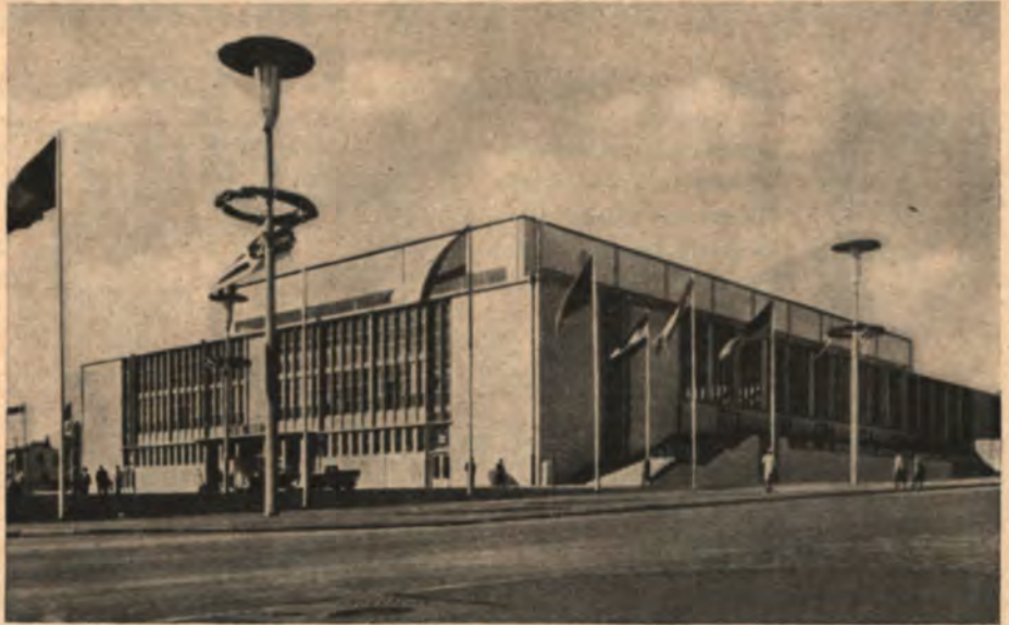
Die Ostseehalle in Kiel
