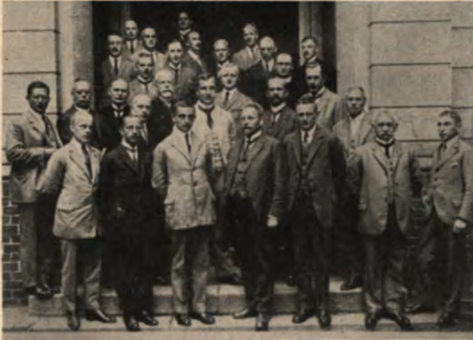
Lehrerkollegium Gymnasium und Oberschule Schneidemühl im Sommer 1925
