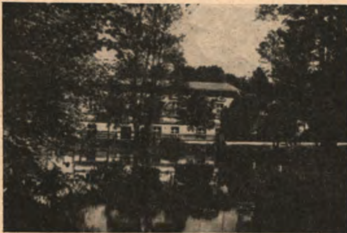
Partie am Mühlenteich
