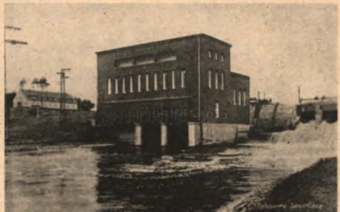
Turbinenhaus des Kraftwerkes Seemühle
