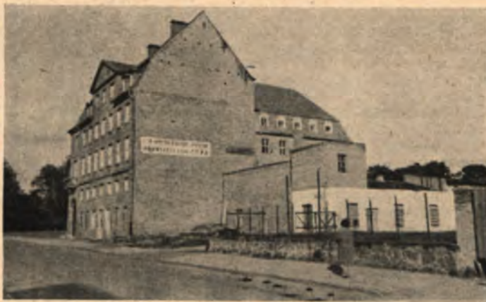
Dies Bild zeigt den aufgestockten und durch Anbau erweiterten Rohbau des Amtsgerichts in der Friedrichstraße. Links sind noch die Bäume des alten Gymnasiums und rechts die Bäume des Schulhofes zu sehen. Das Landgerichtsgebäude auf der Gegenseite ist nur noch eine Ruine. Noch ist aber die Fassade vorhanden. Das zur Milchstraße anschließende Gefängnis ist ganz verschwunden.
