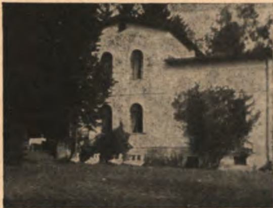
Hier wurde das Forstamt eingerichtet
