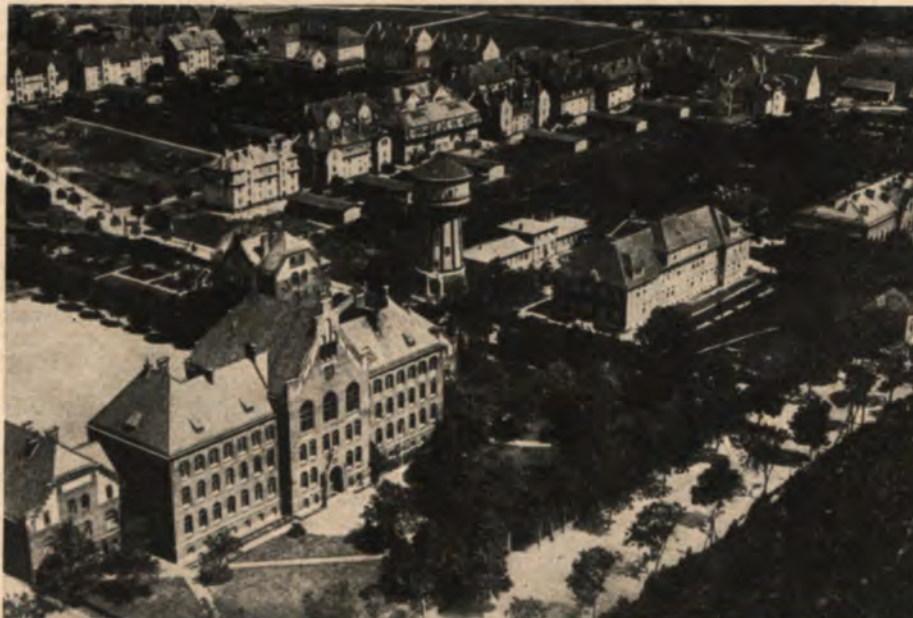
Luftaufnahme vom Schneidemühler Lehrer-Seminar an der Berliner Chaussee. In der Bildmitte der Wasserturm an der Seminarstraße, im Hintergrund die Häuser der Budde-, Sedan- und Westendstraße. Rechts im Bild das noch aus dem 1. Weltkrieg stammte, die Isolierstation des Städt. Krankenhauses.
