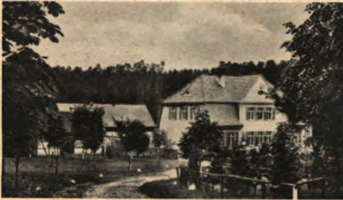
Eingebettet zwischen Wäldern und Seen das Forstamt Schönthal an der Straße Dt. Krone—Jastrow
