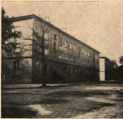
Neubauten an der Ecke Milch- und Kirchhofstraße. Früher befand sich hier die Gärtnerei Schneidewind.
