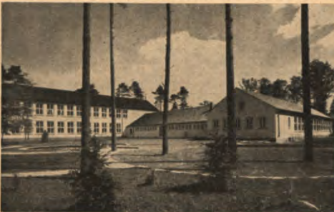
Espelkamp Etwa 1000 Kinder und Jugendliche besuchen in Espelkamp die Schulen. Eines der neuerrichteten Schulgebäude, die achtklassige Ostlandschule
