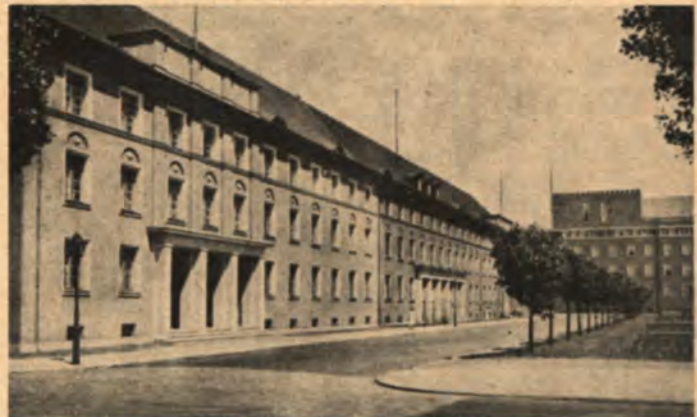
Schneidemühl Danziger Platz mit den Behördenhäusern Hauptzollamt, Konsistorium usw., im Hintergrund das Regierungsgebäude
