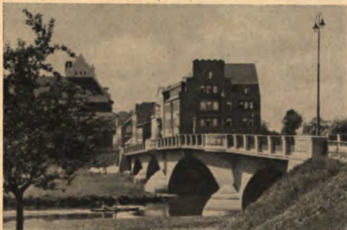
Die „Dr.-Karl-Krause-Brücke“ steht, auch das Café Vaterland. Die Promenade links hinter der Küddow zum Regierungsgebäude ist gesperrt. Sie gehört in ihrer Fortsetzung zum Exerzierplatz der Polizeischule im Regierungsgebäude.
