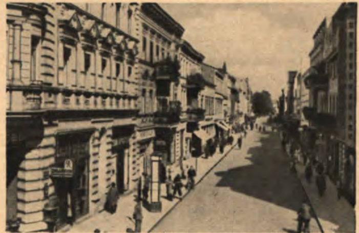
Schneidemühl Blick vom Zeughaus durch die Posener Straße zum Marktplatz. Links das Zentralhotel ist heute Grünfläche, im Wiek'schen Haus (Tachilsik & Bohl) ist das „Warenhaus“.
