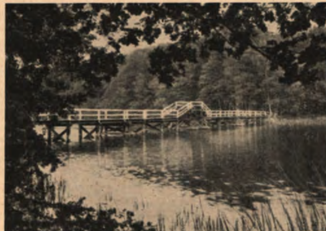
Die Klotzowbrücke in ihrer alten Gestalt
