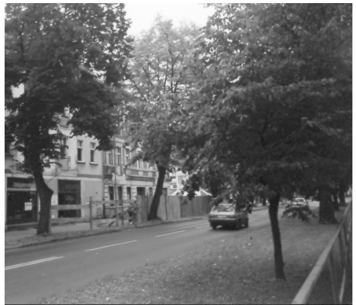
Die Brombergerstrasse im Jahr 2000. Die Häuser wurden abgerissen. Wer hat darin gewohnt ?
