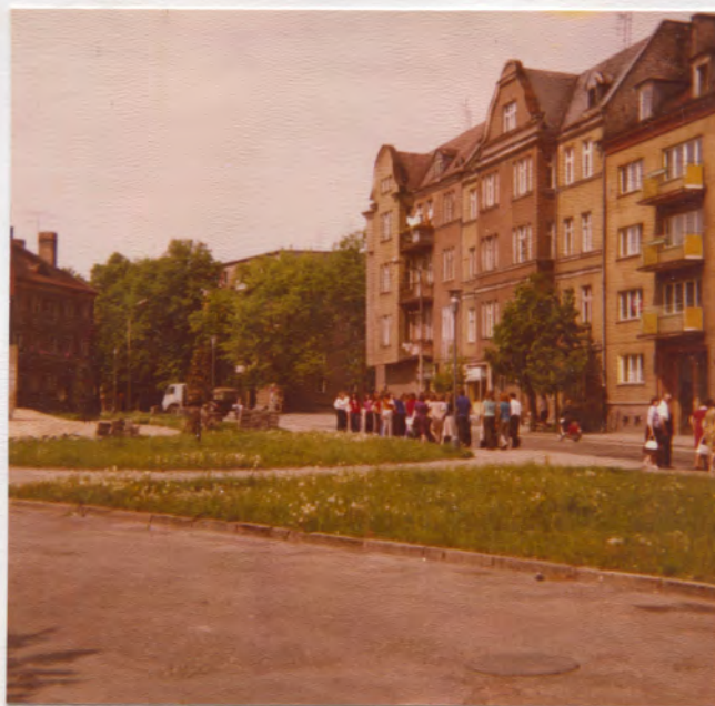
Schneidemühl im Juni 1975 mit dem Wohn- und Geschäftshaus Bismarckstraße 17 - Martha Krause und Nr.17, Besitzer Hermann Ferch aus Koschütz. Es ist auf dem oberen Bild am linken Bildrand zu sehen. Dort, wo am linken Bildrand heute ein Wohnhaus zu sehen ist, stand früher die Johanniskirche.
