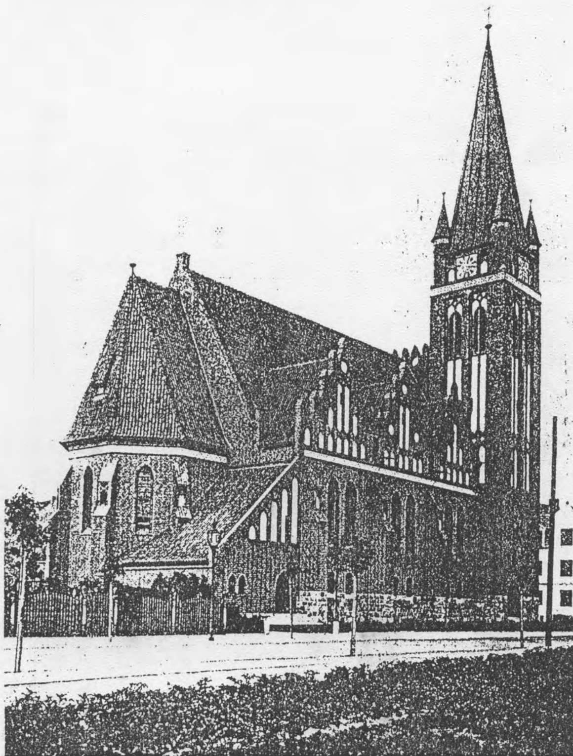
Abb. 7. Südwestansicht. Neue evangelische Kirche in Schneidemühl.
